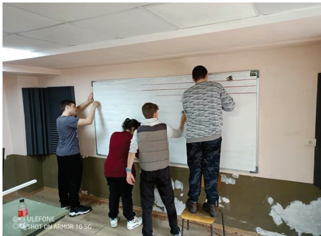
Изграждане на аудио-визуалното студио
